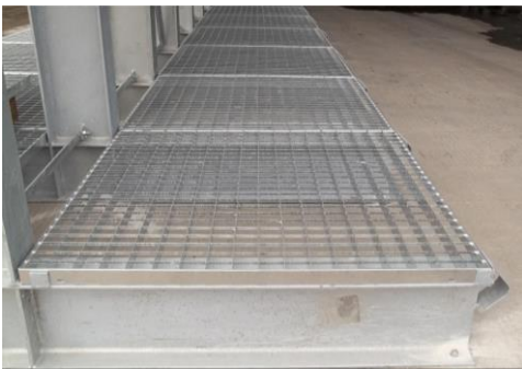
Fußebene mit Gitterrosten:
